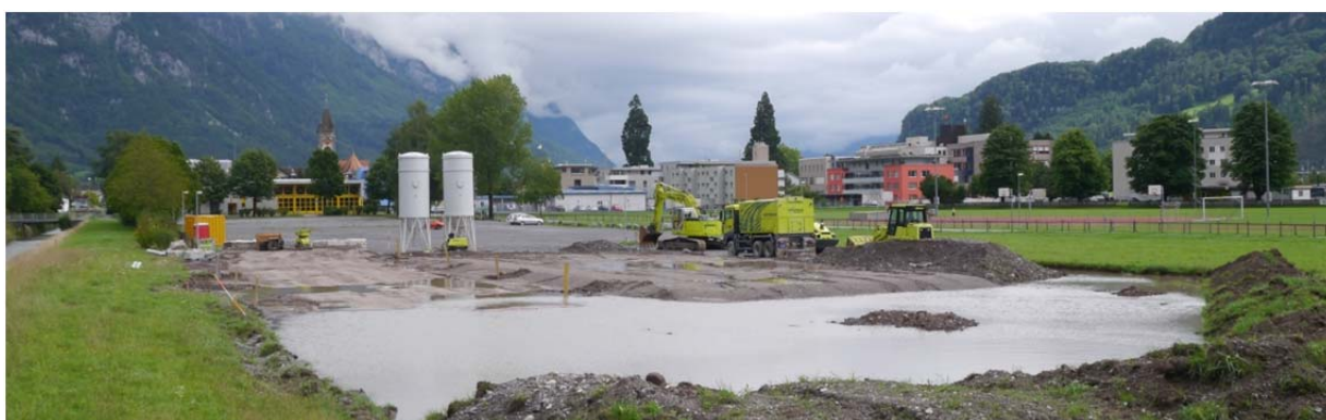
Baustelle „unter Wasser“ Ende Juli 2014
