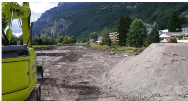
Baustelle Mitte August 2014
